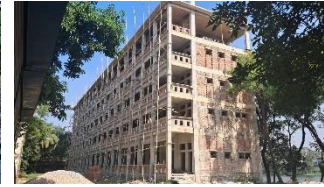
নির্মাণাধীন ৫ তলা একাডেমিক-কাম ওয়ার্কশপ ভবন।
